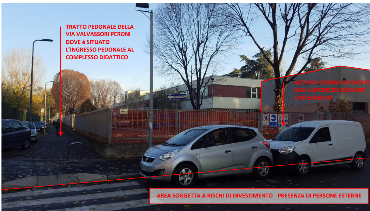
ANGOLO TRA VIA VALVASSORI E VIA VANZETTI CON INDICAZIONE DEGLI ACCESSI
